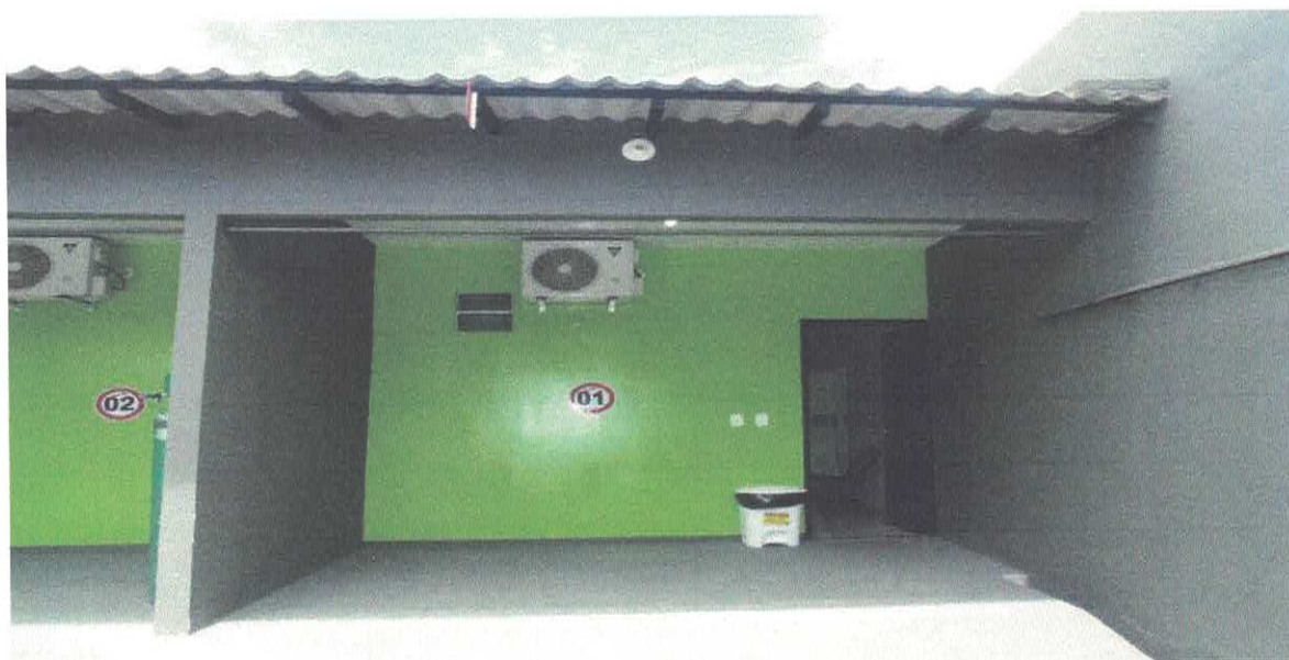
Registro Fotográfico: Fachada do apartamento 1, do hospital de campanha.
