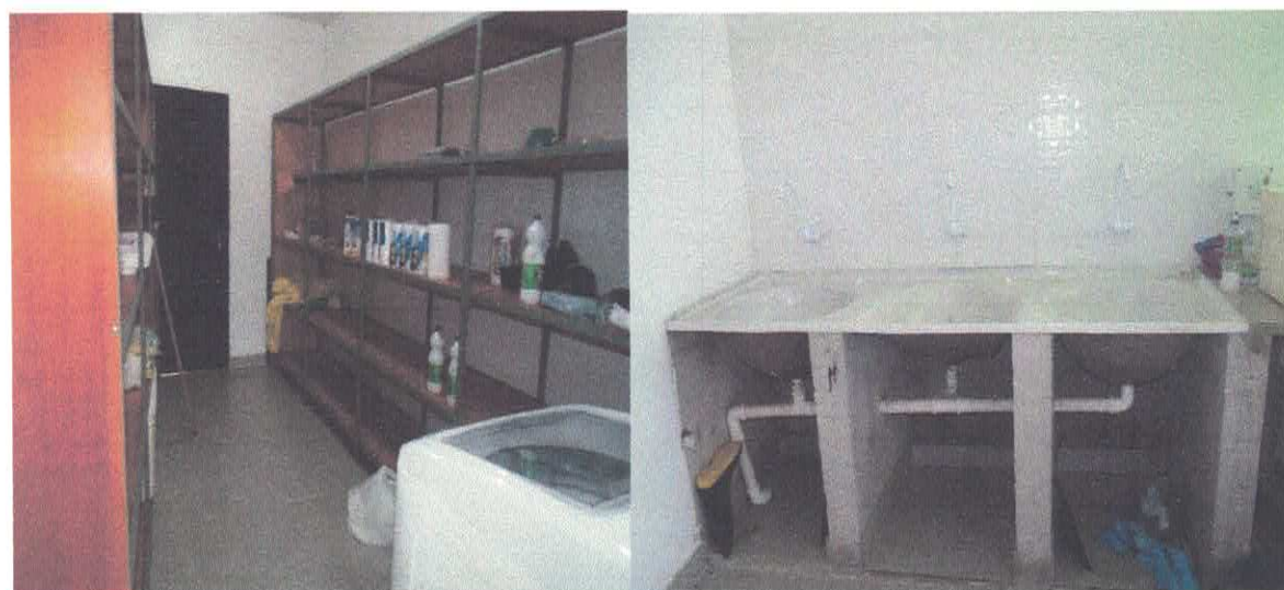
Registro Fotográfico: Área de serviço com lavanderia do hospital de campanha.
